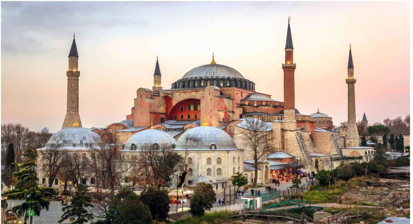
พิพิธภัณฑ์ที่วันนี้คงบรรยากาศของความเก่าชัลงอยู่เต็มเปี่ยม โดยเฉพาะโดมที่ใหญ่ที่สุดเป็นอันดับ 4 ของโลก ซึ่งมีพื้นที่โล่งภายในใหญ่ที่สุดในโลก ก่อสร้างด้วยการใช้ผนังเป็นตัวรับน้ำหนักของอาคารลงสู่พื้นแทนการใช้เสาค้ำยันทั่วไป นับเป็นเทคนิคการก่อสร้าง ที่ถือว่าล้ำหน้ามากในยุคนั้น (ถือเป็นหนึ่งในเหตุผลสำคัญที่ทำให้วิหารฮาเกีย โซเฟีย ได้รับการยกย่องให้เป็น 1 ใน 7 สิ่งมหัศจรรย์ของโลกยุคกลางโบราณ
